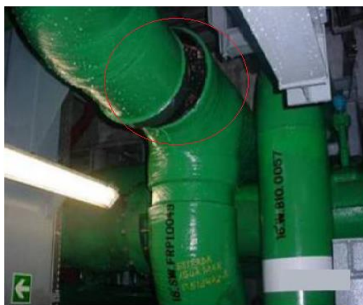
شکل ۲- خرابی دو لوله از محل اتصال چسبی (ریچارد لی [۱۰])
