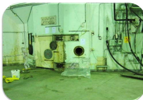
شکل ۴- نمائی از راکتور تحقیقاتی تهران، بیم تیوب‌های آن و بیم تیوب مورد استفاده E در این تحقیق به همراه نمائی از کالیما تور نوترونی طراحی شده
